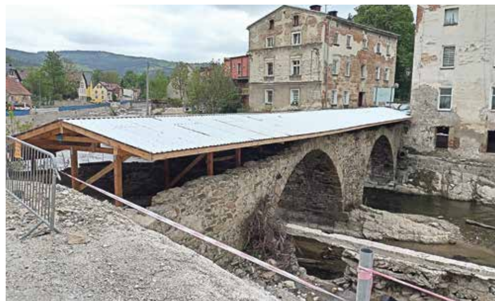
Zabezpieczony gotycki most z XVI wieku
