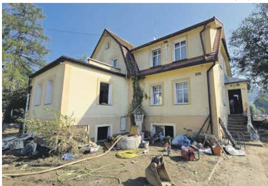
Dotknięty powodzią budynek w Kotlinie Kłodzkiej
