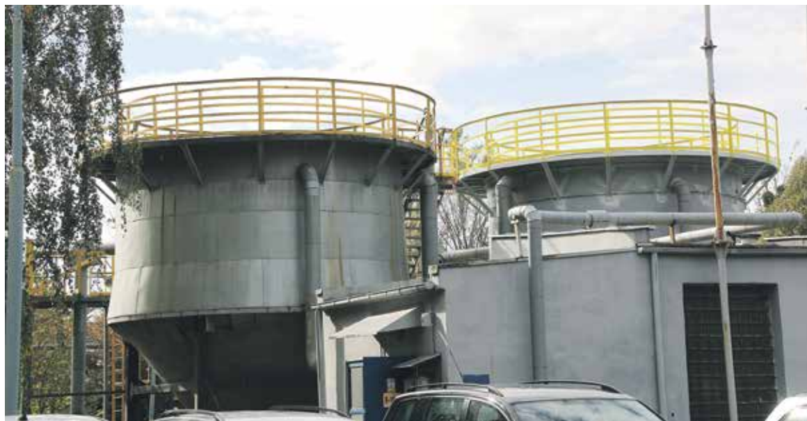
Osadniki oczyszczalni ścieków
