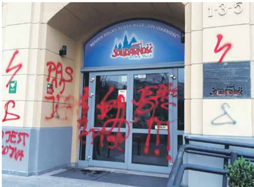
Elewacja budynku dolnośląskiej „Solidarności” po jednej z demonstracji Strajku Kobiet
