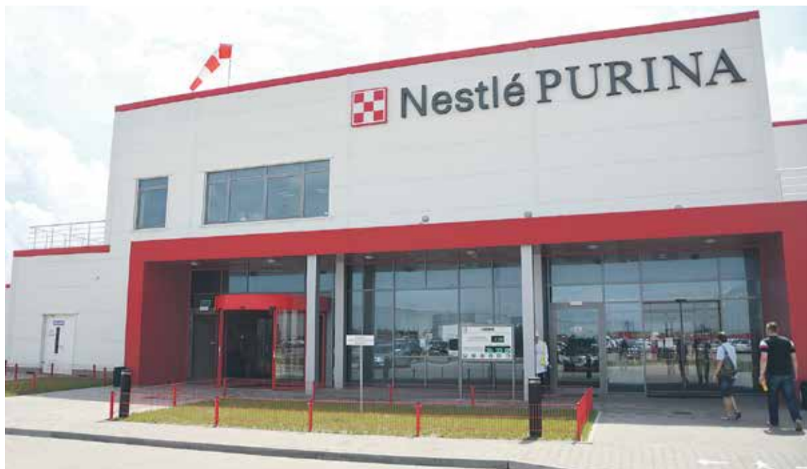
Wejście do zakładu
