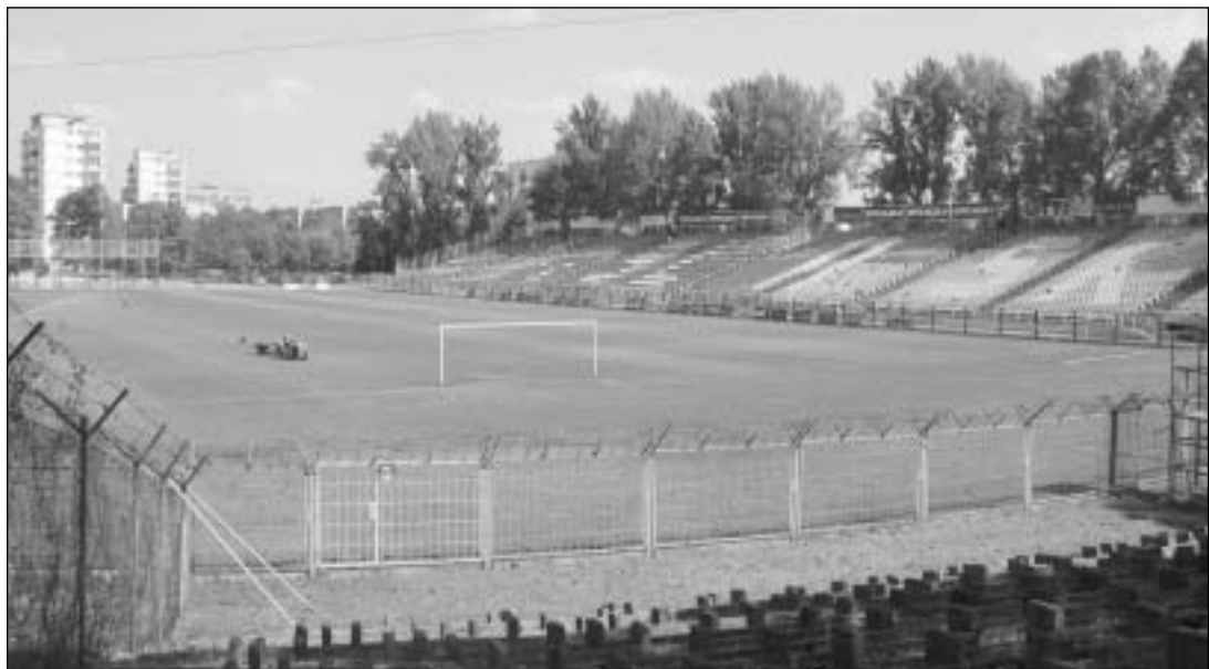
Stadion Śląska Wrocław przy ul. Oporowskiej.
